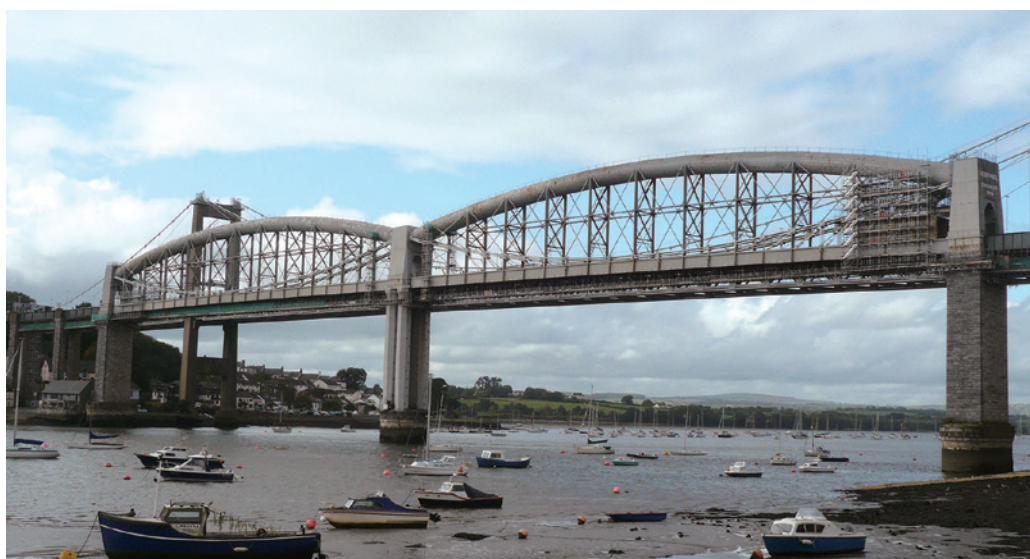
ロイヤルアルバート橋 (Royal Albert Bridge、1859)
