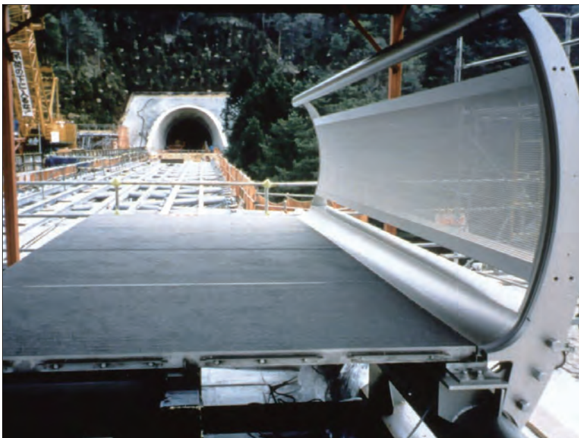
床パネルの断面(施工中)
