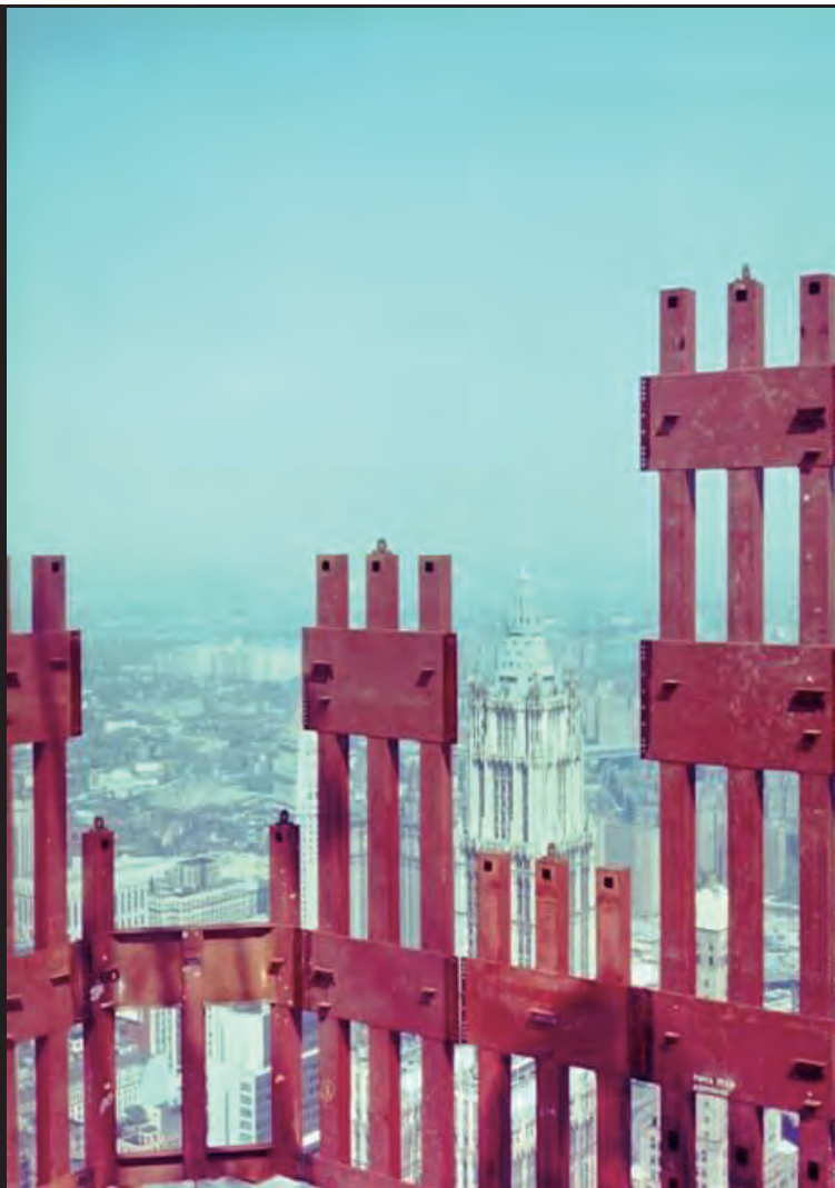
外周柱と フロアーデッキ・小梁
