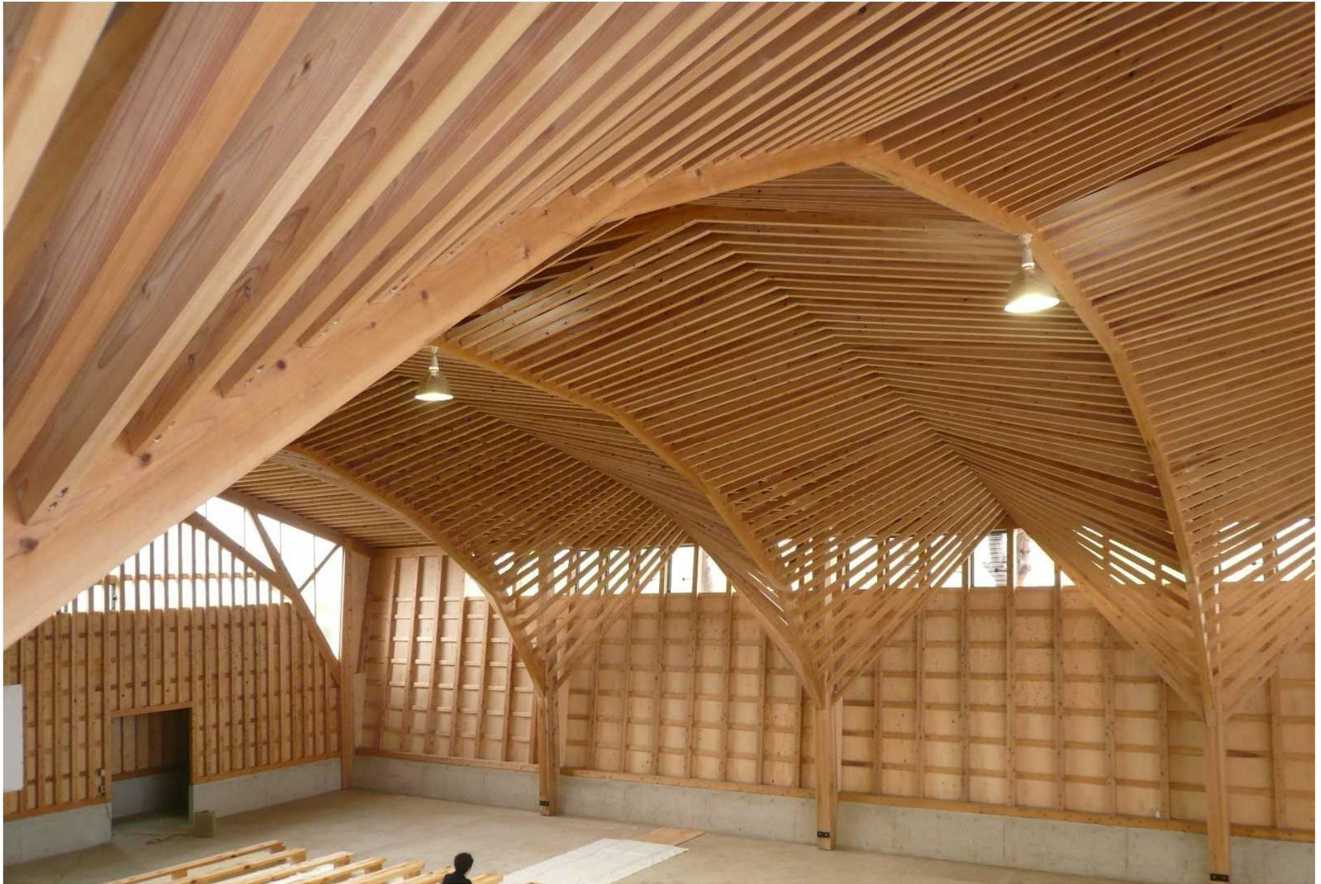
長野県産スギ製材だけを用い、地場の大工・工務店だけで加工・施工を行った大規模木造。地場製材と地場工務店による「地産地消」の大規模木造は、森林環境問題と地域産業振興の両方の手助けとなる。
