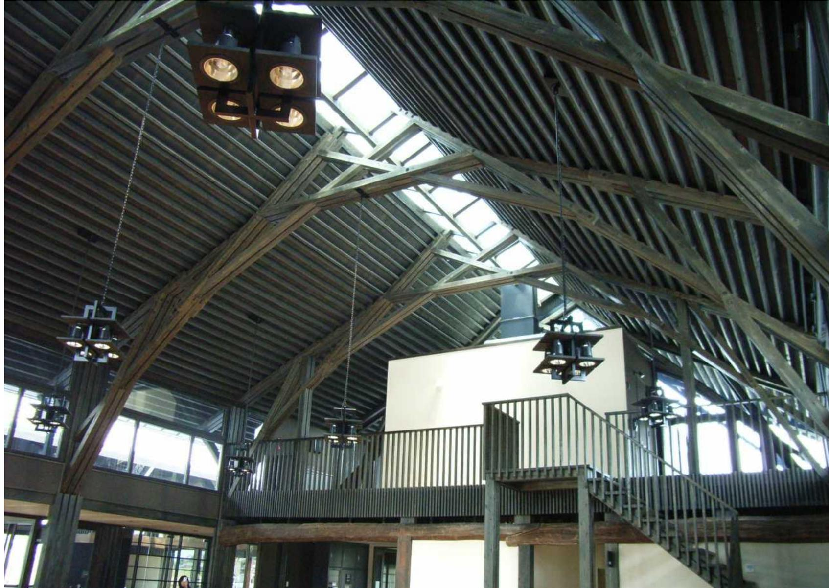
スギ105角2～4本を35mm隙間をあけて並べ、継手・仕口は17.5mmずつ相欠きし、
