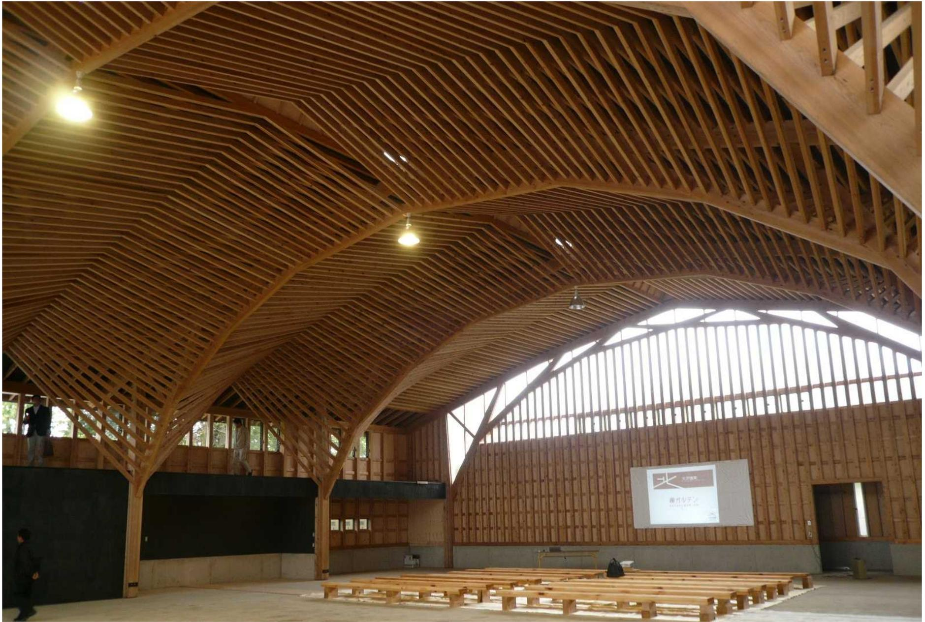
樹状方杖架構＋ルーバー状の方杖・母屋で屋根荷重を分散してアーチ状に軸力伝達した合理的な構造によって、長野県産スギ製材だけで18mスパンの大空間を実現
