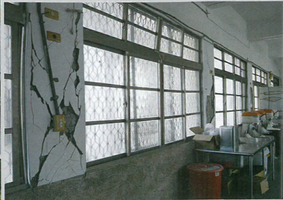
【写真7】校舎の柱がせん断破壊 台南市玉井区の中学校「玉井国中」の特別教室棟の校舎（上3点）。98年に完成した地上3階建てのRC造で、片廊下式の平面形状を持つ。短柱や円形開口のある壁にせん断ひび割れが生じた。渡り廊下でつなぐ教室棟に被害はなかった。下2点は97年完成の体育館。外壁の落下や、タンクの転倒などの損傷が見られた
