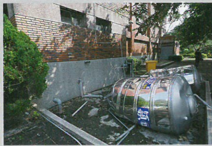
【写真7】校舎の柱がせん断破壊 台南市玉井区の中学校「玉井国中」の特別教室棟の校舎（上3点）。98年に完成した地上3階建てのRC造で、片廊下式の平面形状を持つ。短柱や円形開口のある壁にせん断ひび割れが生じた。渡り廊下でつなぐ教室棟に被害はなかった。下2点は97年完成の体育館。外壁の落下や、タンクの転倒などの損傷が見られた
