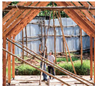
建築家は現場常駐し職人との調整を行う
