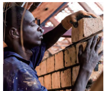
手製の焼成煉瓦の丁寧な選択と積み上げ
