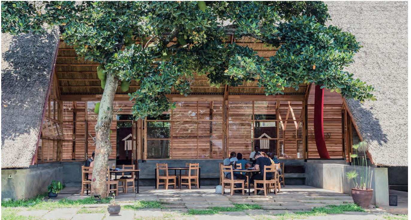
東立面、煉瓦とRCで造られる基礎は、緩やかな斜面地にフレームを支える水平面を提供している。
