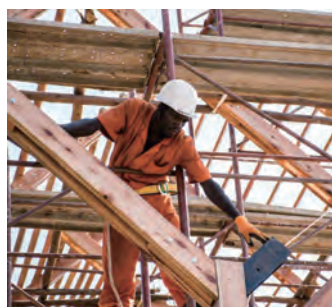
フレーム上部は立上げ後に大工が部材接合
