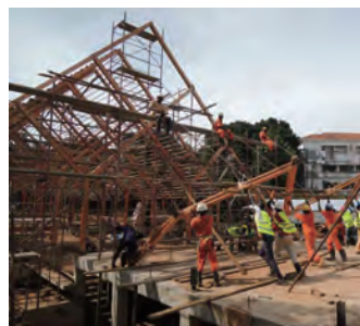
重機を用いず人力で16のフレームを建ち上げ
