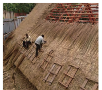
地元の茅葺職人による屋根葺き作業
