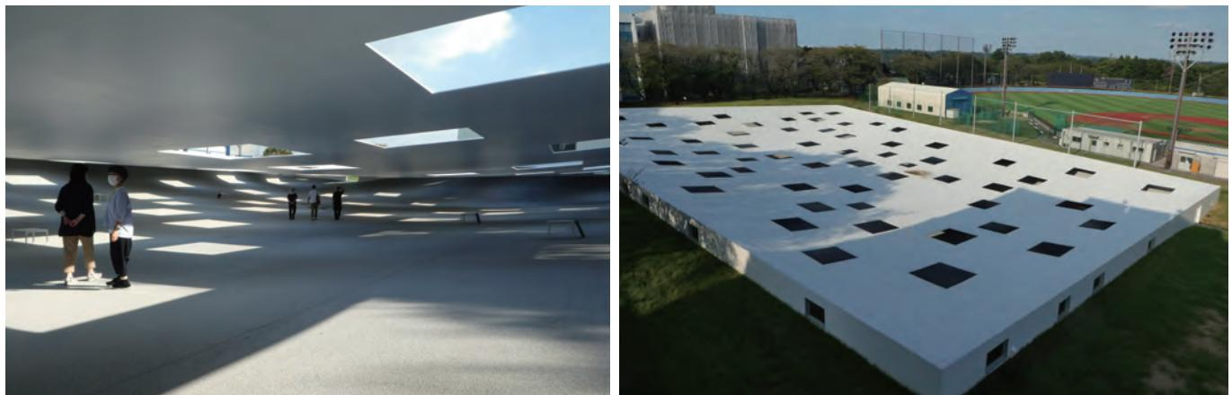
【講評】「建築が風景になりえるか」という建築家の想いでつくられた建築は、少し窪んだ地面の上に4000m<sup>2</sup>の懸垂屋根がかかるだけのシンプルな空間である。ゆるやかに垂れ下がった屋根は厚さ12mmの鋼板一枚で出来ている。薄い板が垂れ下がっただけの一見単純な構造であるが、単純なものほど難しい。そこにはものすごいスタディとエンジニアリングが込められている。
