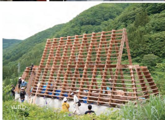
【応募理由】「まれびとの家」は、既存の職能・領域を超えた議論と試行錯誤の上できあがった建築である。3D木材加工機「ShopBot」と地元の木材を使い、製作を地域完結させることで、これまで避けられなかつた長距離輸送や環境負荷、時間、コストを削減することができており、現地の素材生産者が木材をデジタル加工することで、既存のバリューチェーンを介さずに、直接エンドユーザーに製品を届けられる仕組みのためのプロトタイプといえる。また、「伝統×デジファブ」というテーマを掲げ、「合掌造り」と「ワクノウチ」を参照し、「Aフレームトラス」と「貫による半剛接構造」という2つのシステムをクリアランス0.25mmの嵌合で実現している。(金田泰裕)
