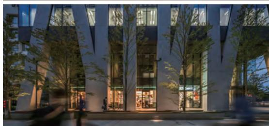
ス部から住宅部へ切り替わるところで枝分かれし、内部の空間構成に対応して細くなる。また地面のレベルでは柱が集約されて、外から人を招き入れやすいようにしている。不均等に斜めに伸びた構造は、前面のケヤキ並木とも呼応して、都市景観の形成にも寄与している。異なる機能を合理的に接続し、その表現が外観にも表現されたこのビルは、超高層建築の自由なデザインを切り拓いていくものとして評価できるものである。（磯）
