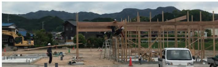
【講評】陶磁器を企画製造する企業の、陶磁器やアート作品のショップ、カフェ、公衆トイレ等で構成された施設である。4000 m<sup>2</sup>ほどの敷地に配された木造平屋の建物は「ありきたりな材料とローテク」で特別な技能を持たなくとも構築できるように工夫されている。柱は45×105ダブル、直行する梁はそれぞれ45×300ダブル、45×270シングルと、材幅は45mmに統一され、必要長さにカットした部材同士をボルト留めしてゆくだけのシンプルな架構であり、素人でも施工が可能な単純なシステムとなっている。「派手さやアクロバティックさとは別のところにあり、かといってミニマルを目指すわけではない絶妙な解答を目指した」と作者が言う通り、即物的ではあるが洗練的な美しさのある空間が出来上がっている。伝統的な技能や特殊な技術を必要とするものではなく、プレカットのような規格にとらわれることのない構築法はこれから木造構法のありかたの一つを示している。肩に力をいれることなく“さりげなく”新しいことにチャレンジしようとする、作者の人柄を感じさせる作品である。(陶器)
