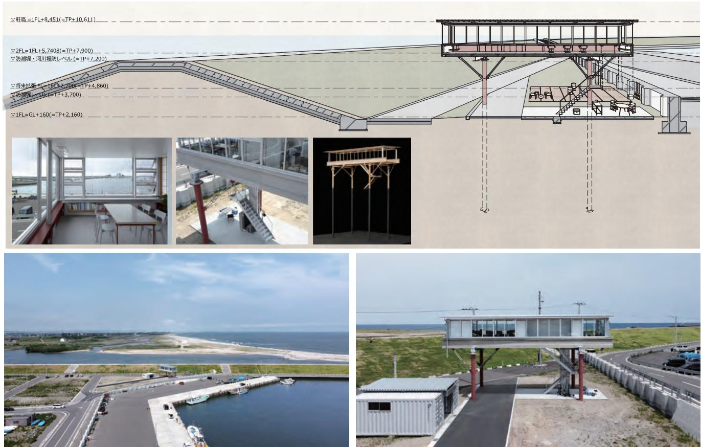
【講評】強い建築である。敷地は東日本大震災の被災地の海と川に挟まれた軟弱地盤にある。海側に防潮堤、川側の堤防に囲まれ、地上面からは何も見ることができないにもかかわらず、オフィスを建てるようになった。失われた眺望を取り戻すため、橋梁のパイルベントという工法を用いて、杭を地中の支持地盤に打ち込みながら空中まで立ち上げている。現代の掘立柱のように、防潮堤の上に建築を持ち上げようとする野心的な建築だ。
