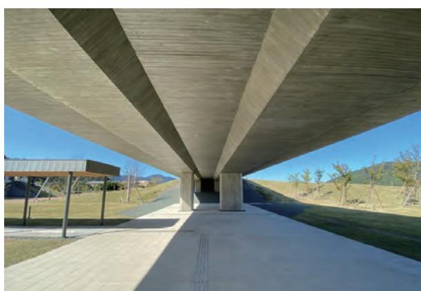
【講評】ピロティで持ち上げられた展示室が水平に長く延びる。屋根の形は、左右対称のシンプルな切妻。しかしこれを支える内側の架構は、左右非対称だ。そして1階に2列で並ぶRCの柱も、太さが異なっている。非対称の理由は、2階にあるRC造の壁が中央からずれた位置に配されており、その上に屋根架構が載っているからだ。ミュージアムの設計では、展示の自由度を高めるため、展示壁と躯体とができるだけ分離させることが一般的だが、この施設では主要な展示物の形状から導き出される横に長い1枚の展示壁が、その配置によって合理的な平面を生み出すと同時に、構造をも担っている。意匠と構造が非常に高いレベルで統合された建築だ。選考委員の一部からは、屋根は対称形でなくてもよかったのではないか、という疑問が呈されたが、両側に開けた周囲のランドスケープとの関係を考えると、この形状にこだわった理由は十分にあると考える。最終選考のプレゼンテーションでは、設計の初期段階で想定していた木造の架構から、実施案である鉄骨を組み合わせたハイブリッド架構に変えたプロセスも丁寧に説明された。これも十分な説得力があるものだった。（磯）
