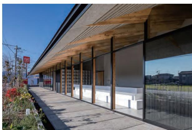
【講評】CLT は使えそうで使いにくい建材である。木材で大判パネルであるということが最大の特徴であるが、曲げに対して異方性が大きく、CLT を用いた建築は単調な空間になりがちである。
