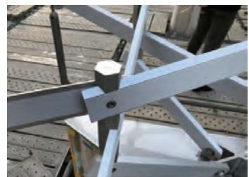
【講評】音楽の専門教育を行なう学園のキャンパスにある屋外ステージで、昼休みやイベントの際には演奏会が行われる。その上に架かるパーゴラ状の屋根である。アルミの線材をつなぎ、カゴメ状に編んでいくことによって、3次元の自由曲面を生み出している。全体形状の決定から構造設計、そして精巧ではあるがシンプルな接合部のディテール検討まで、デジタルデザインの手法を活用した。アルミ部材の製作もデータの受け渡しにより、高い精度で実現させている。これにより施工も簡略化され、特殊な重機を用いず人の手によって短工期でつくることができたという。建築に使われる素材として、木材はローテックでアルミはハイテックといったような思い込みがあったが、このプロジェクトでは日本の木造建築に見られる伝統的な継ぎ手を想起させる接合方法をとることで、アルミという素材を、ハイテックであると同時にローテックでもあるものと再定義している。（磯）
