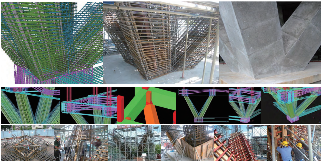
▲ 鉄筋工事のワークフロー（2006）
