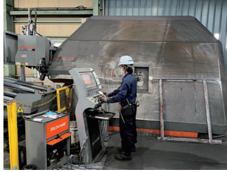
定尺鉄筋を引き込み、加工、切断
