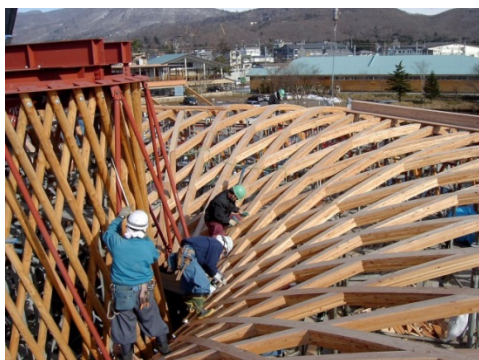
写真 4.2-1 屋根ラチスと中央ラチスを丸パイプで接合する
