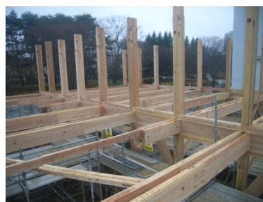
写真 2.1-2 組立式ラーメンの建方
