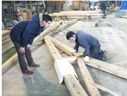
写真 4.1-2 小塩江中学校体育館 モックアップによる 接合部の確認
