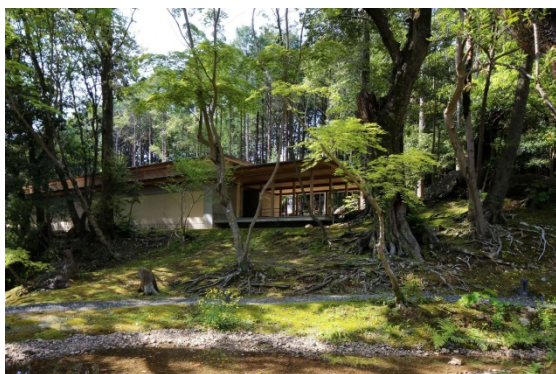
写真 3.2-1 竹林寺納骨堂 外観 (撮影: 堀部安嗣)
