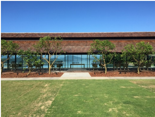
写真 3.3-1 エレテギア 外観
