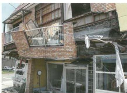
益城町 鉄骨造住宅の被害
