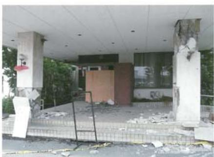
医院の玄関ピロティ 上部を支える柱が損傷
