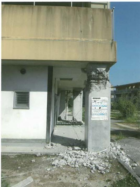
宇土市公営住宅 新耐震ピロティの柱が損傷
